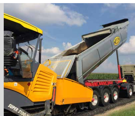
Teerdeckenfertigung: Bei geschlossener Plane behält der Asphalt seine benötigte Temperatur.
